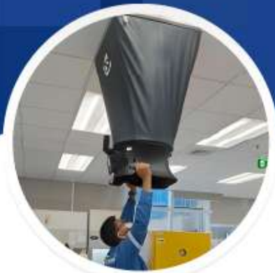
การตรวจวัดและประเมิน ระบบระบายอากาศ
